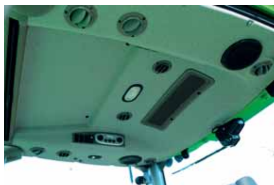
W podsufitce ciągnika Deutz-Fahr 5110 G przygotowane jest miejsce pod okno dachowe.
