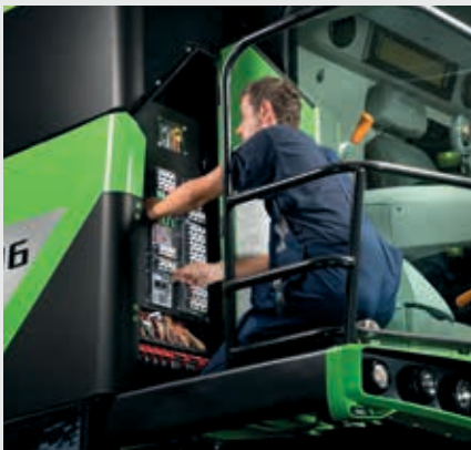
↑ Gemakkelijke toegang tot de zekeringenkast.
